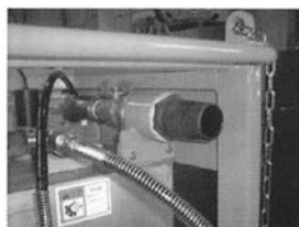
定流量弁で流入量の安定化実現。
