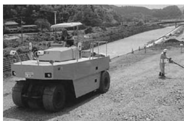
GNSS 転圧管理システム
