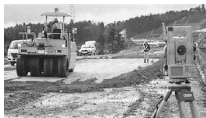
TS 転圧管理システム
